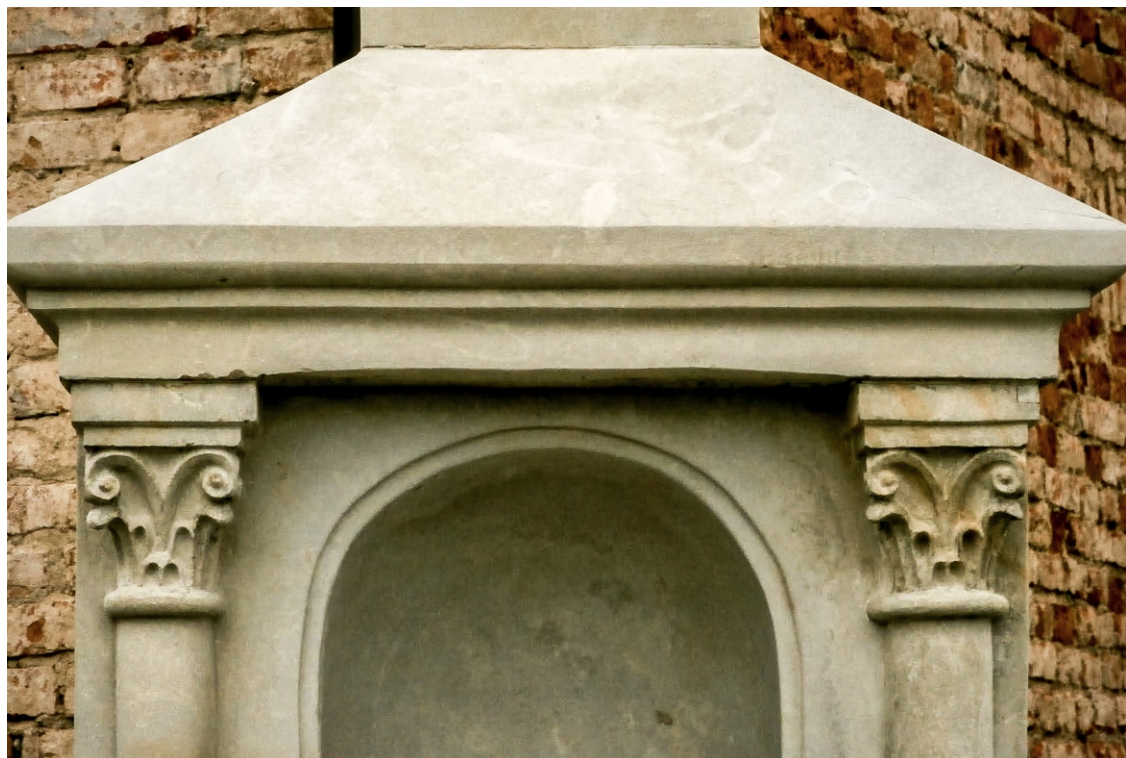
Stan po renowacji.
