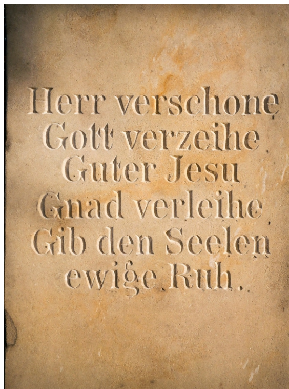
Stan po renowacji.
