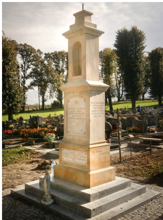
Stan po renowacji.
