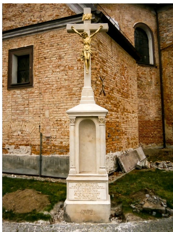
Stan po renowacji.
